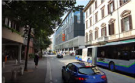
Ristrutturazione centro commerciale Cooperativa Migros Ticino LUGANO
