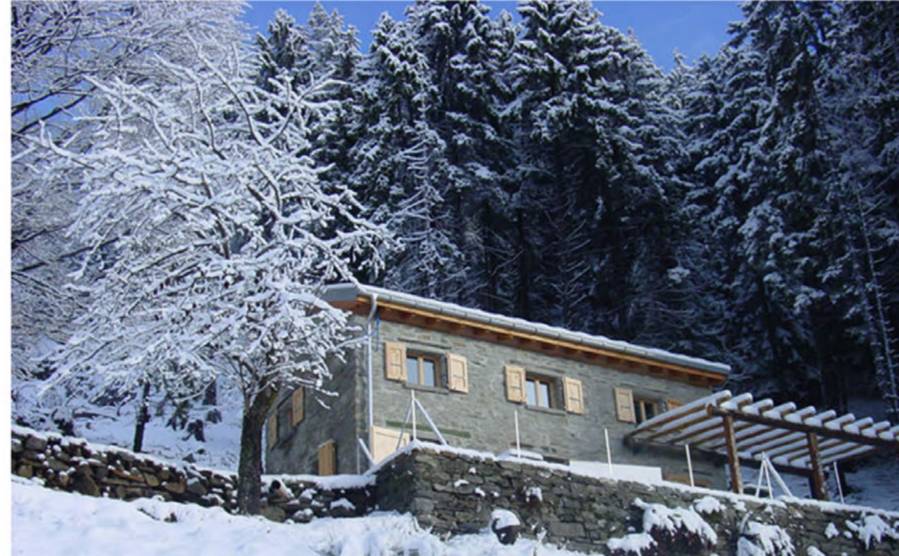
Rustico Viscardi, ristrutturazione SAN VITTORE
