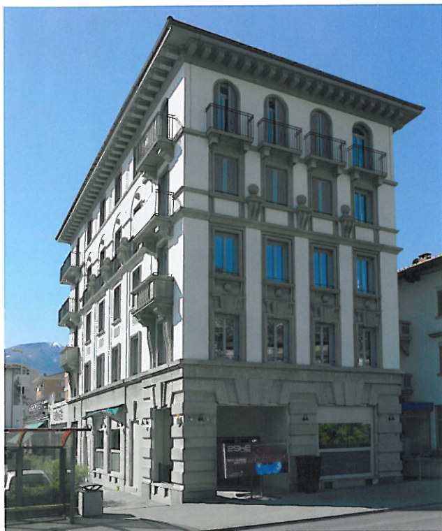
La facciata non tradisce l'opera di risanamento dell'edificio...
